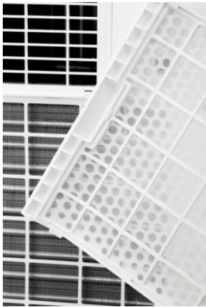
Pic1. Apague la unidad y retire los 2 filtros de aire.
